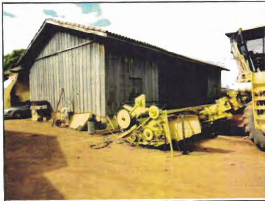
Foto 09 – Vista do barracão.
