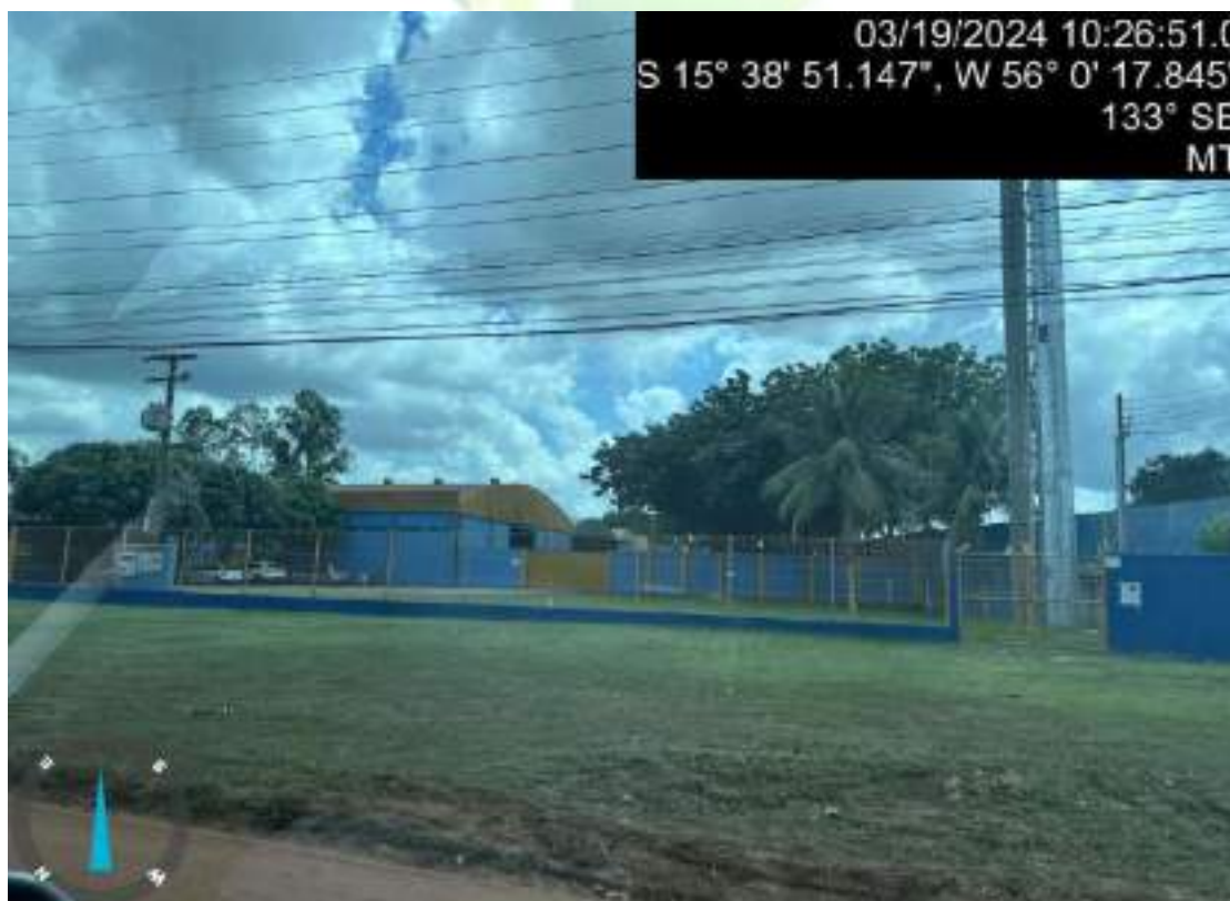
Figura 6: Frente do imóvel
