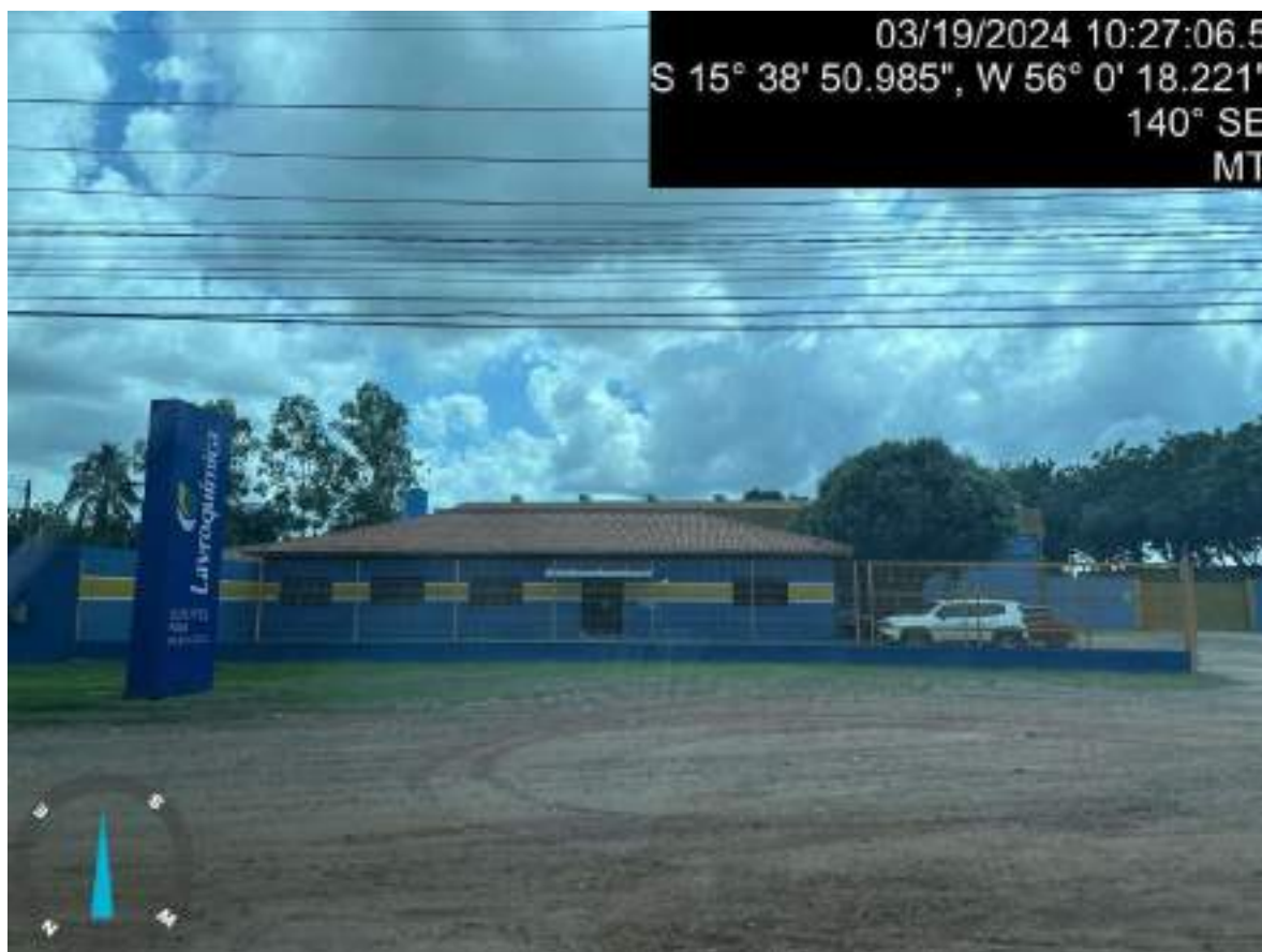
Figura 5: Frente do imóvel
