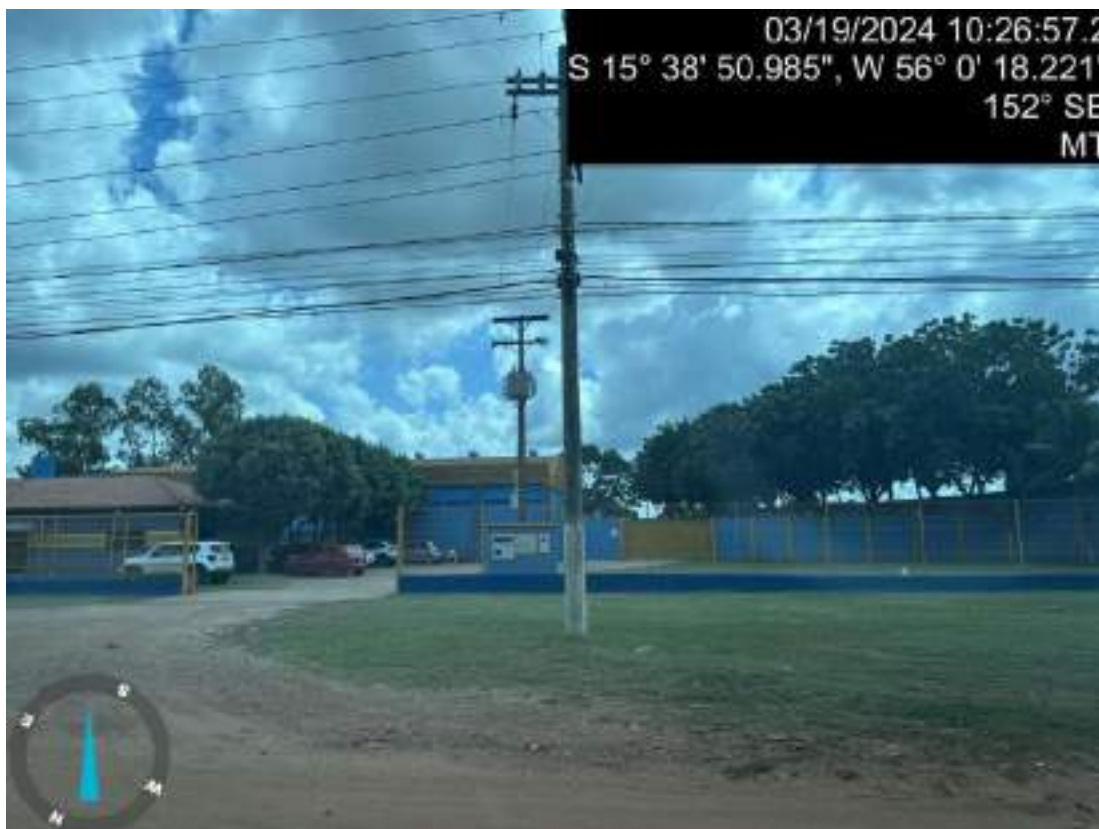
Figura 6: Frente do imóvel
